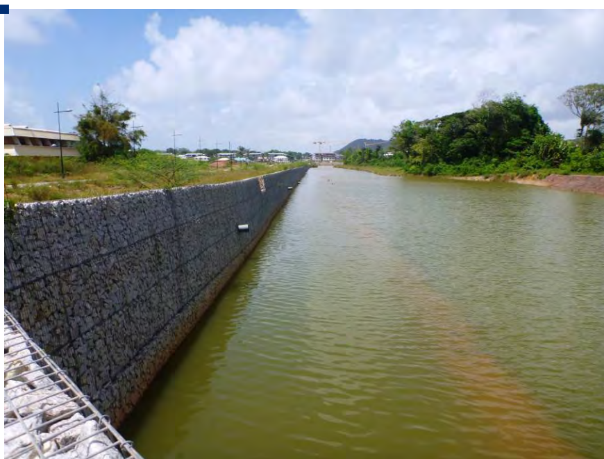
Figure 29 : L'intégration paysagère des bassins de rétention des eaux pluviales est un élément à considérer – Zone Hibiscus Cayenne – (L. Riera / HYDRECO)
