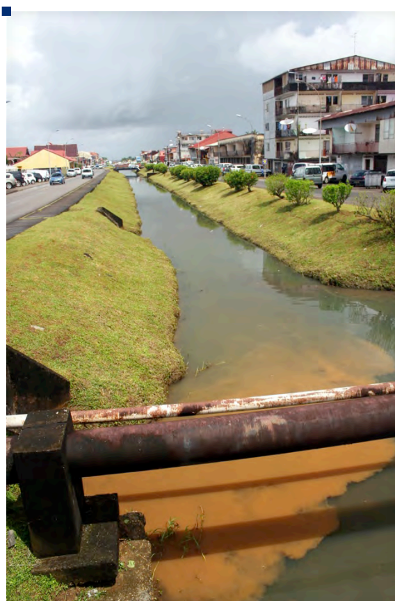
Figure 39 : L'épuration du canal Laussat à Cayenne permettrait un réinvestissement de cet espace par les riverains et bénéficierait au secteur touristique (R. Vigouroux / HYDRECO)
