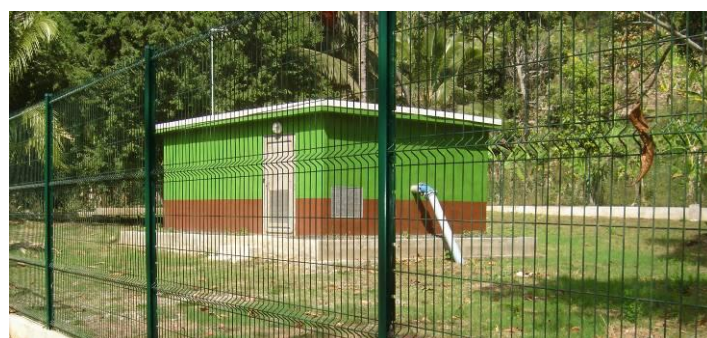
Captage de Bouyouni
