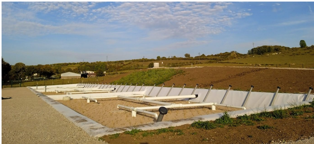
Figure 11 Station à filtre planté de roseaux de la commune d'Einviaux - Travaux terminés 2024 - crédit photo AERM
