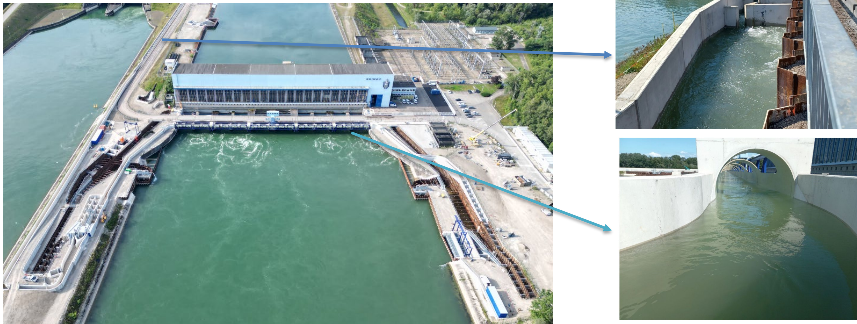
Figure 20 Mise en eau de la passe à poissons de l'usine hydroélectrique de Rhinau - juillet 2024 - source EDF
