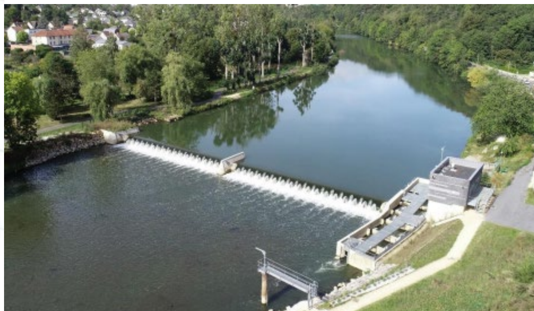
Figure 19 Ensemble des barrages restaurés sur la Meuse dont la photo du barrage à bouchures gonflables à Montcy-Notre-Dame (Ardennes) - crédit photo BAMEO/VNF
